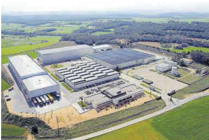
La planta de Garcia de Pou a Ordis.
